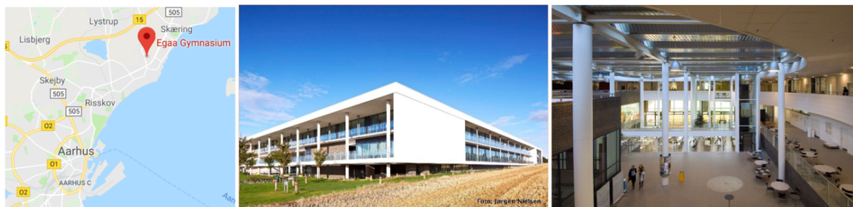
Figur 2 - Egaa Gymnasium, bygget i 2005/06. Egaa Gymnasium startede sommeren 2005 med fem klasser. Den første årgang blev undervist i barakker det første år, mens skolen blev bygget lige ved siden af. I august 2006 flyttede ni 1.g klasser ind i den nye bygning sammen med første årgang. Skolen er siden blevet udbygget med et musikhus, og rummer i dag ti klasser på hver årgang. Af de ti spor på skolen er de fire naturvidenskabelige, med kombinationerne Biologi A og Kemi B; Fysik A, Matematik A og Kemi B; Kemi A, Matematik A og Fysik B samt Bioteknologi A, Matematik A og Fysik B.
